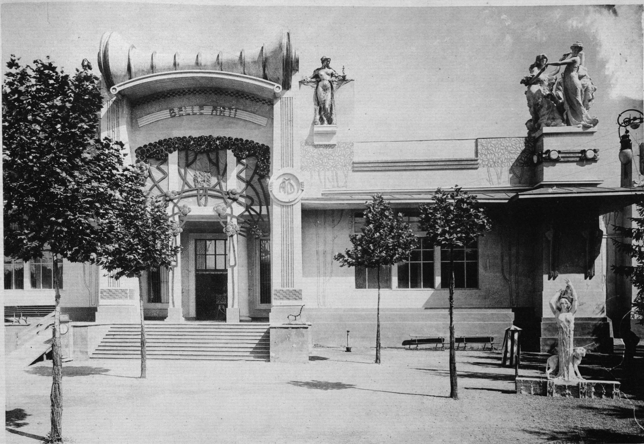
Ingresso Sud alle Belle Arti - Arch. R. D'ARONCO
