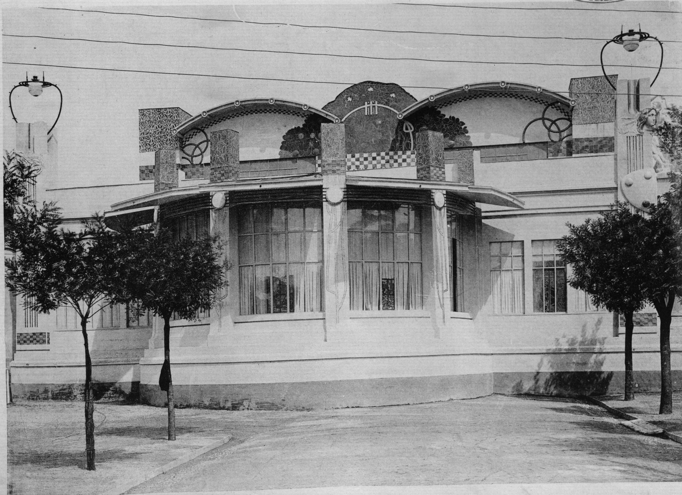
Esterno della grande Galleria - Arch. R. D'ARONCO
