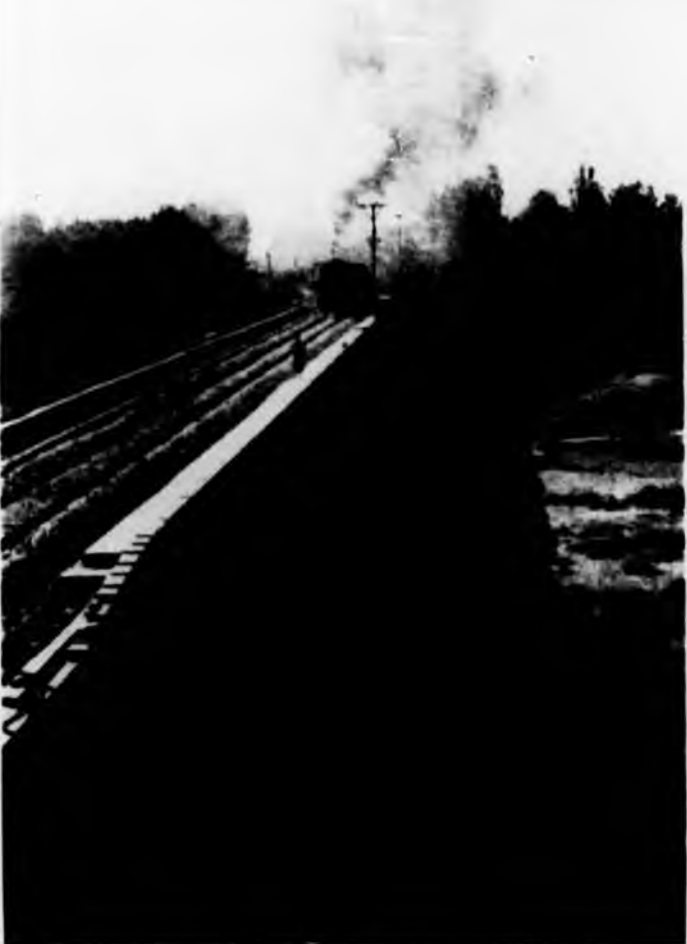
Strada prov. Airasca-Villafranca Ponte promiscuo sul torrente Chisone - fra Vigone e Villafranca P. (in via di ultimazione)
