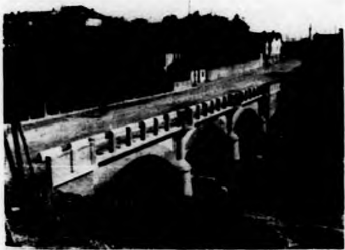
Strada prov. Torino-Orbassano-Piussasco Ponte sul Sangone presso Beinasco
