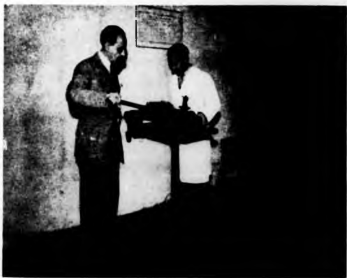
Sincinesiografo. Apparecchio per lo studio della coordinazione dei movimenti per le professioni che richiedono motricità.
