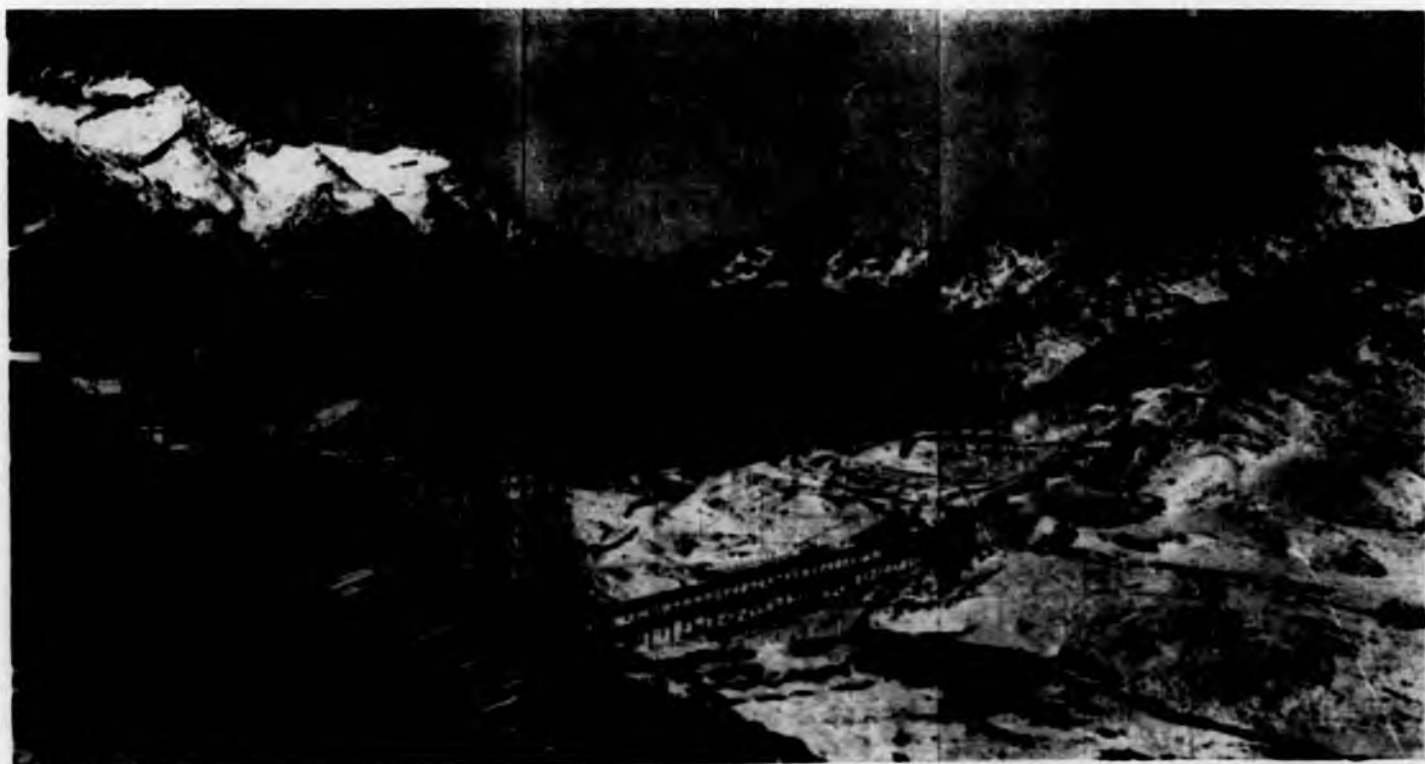
Cantiere per la costruzione della diga Lago Serrù (Marzo 1949).
