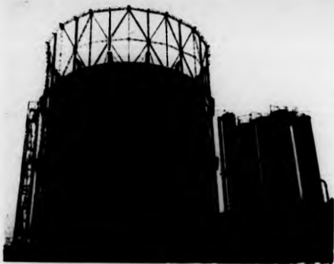
Fig. 3. - ...lavatori (a destra della fotografia) che trattengono ammoniaca, benzolo e naftalina. A sinistra vi è uno dei serbatoi del gas o gasometro.
