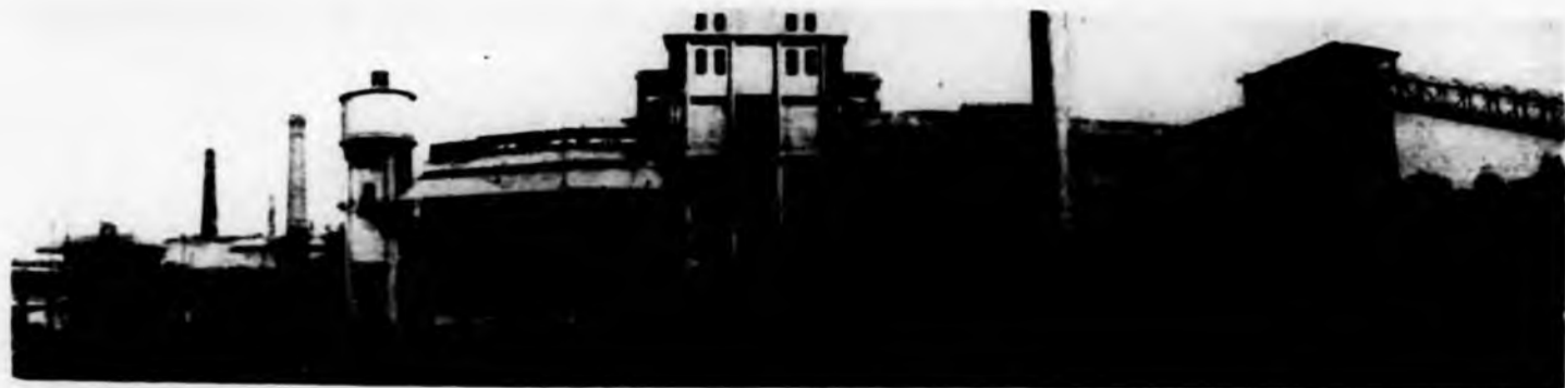
Fig. 1. - L'imponente fabbricato dei forni comprende 74 camere di distillazione nelle quali si introduce il fossile e se ne estrae gas e coke. - A sinistra vi è il condensatore del gas ed a destra il silos per classificare il coke.
