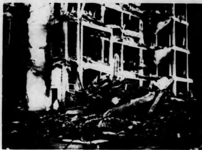
Come è stato ridotto il bellissimo moderno edificio scolastico di Via Valperga Caluso angolo Via Belfiore
