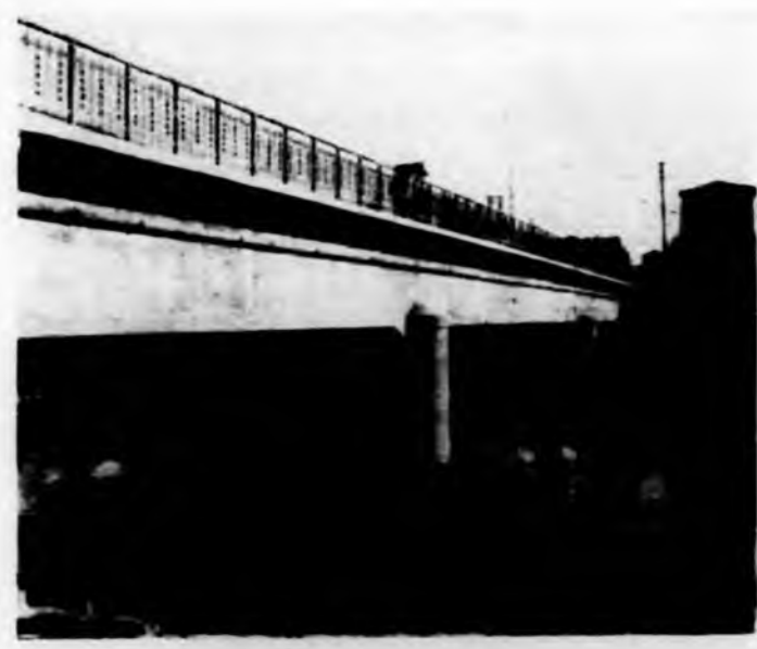
Strada prov. Leyni-Fogizzo Ponte sul "Malone", presso S. Benigno
