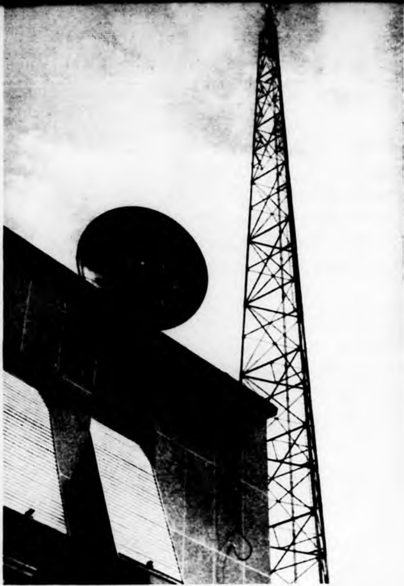
Antenne traforate per Televisione. Specchio parabolico per i ponti aerei.
