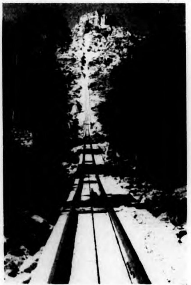
Lavori in corso impianto Rosone-Telesio. Piano inclinato e sede condotta forzata.
