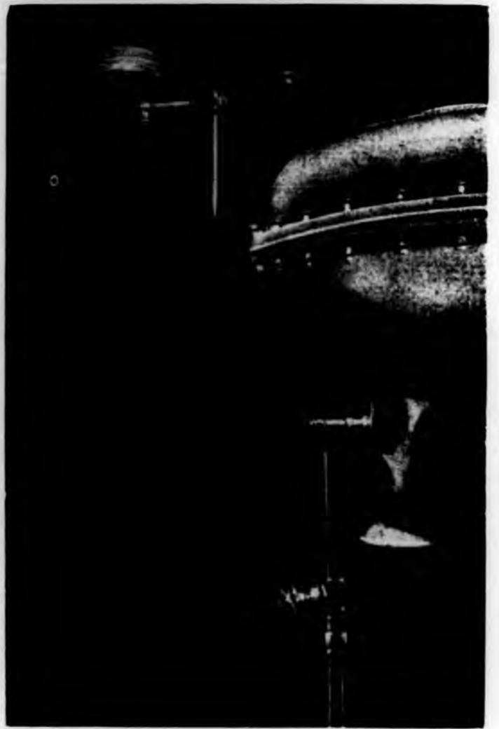
Fig. 8. - Ridotto di pressione il gas viene immesso nella rete normale con questi tipi di riduttori.
