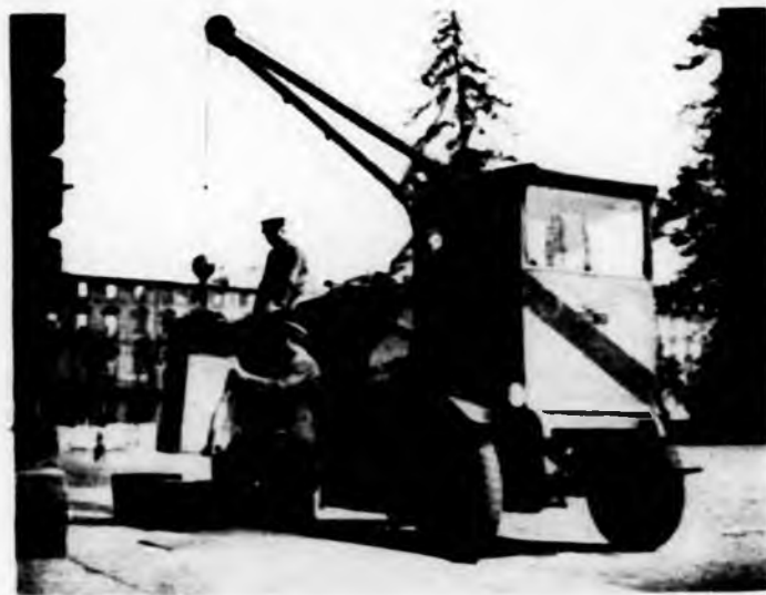
Lo svuotamento meccanico dei moderni pozzetti stradali.
