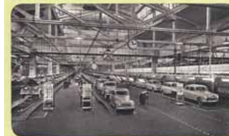
Fiat-Mirafiori - Lines di montaggio. - Lignes de montage. - Assembly lines. - Líneas de montaje. - Montagelinien.
