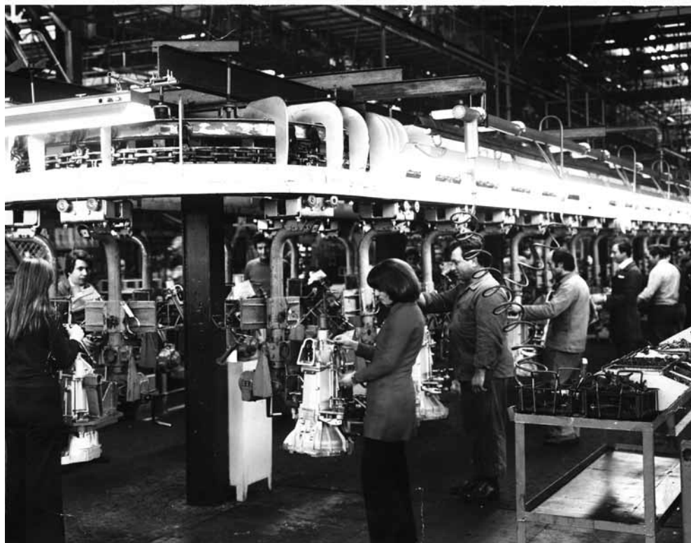
Fiat. Stabilimento di Termoli (CB). Linea montaggio cambi, 1977 (ASCT, Archivio «Gazzetta del Popolo», sez. I, Fiat C9, foto 21).
