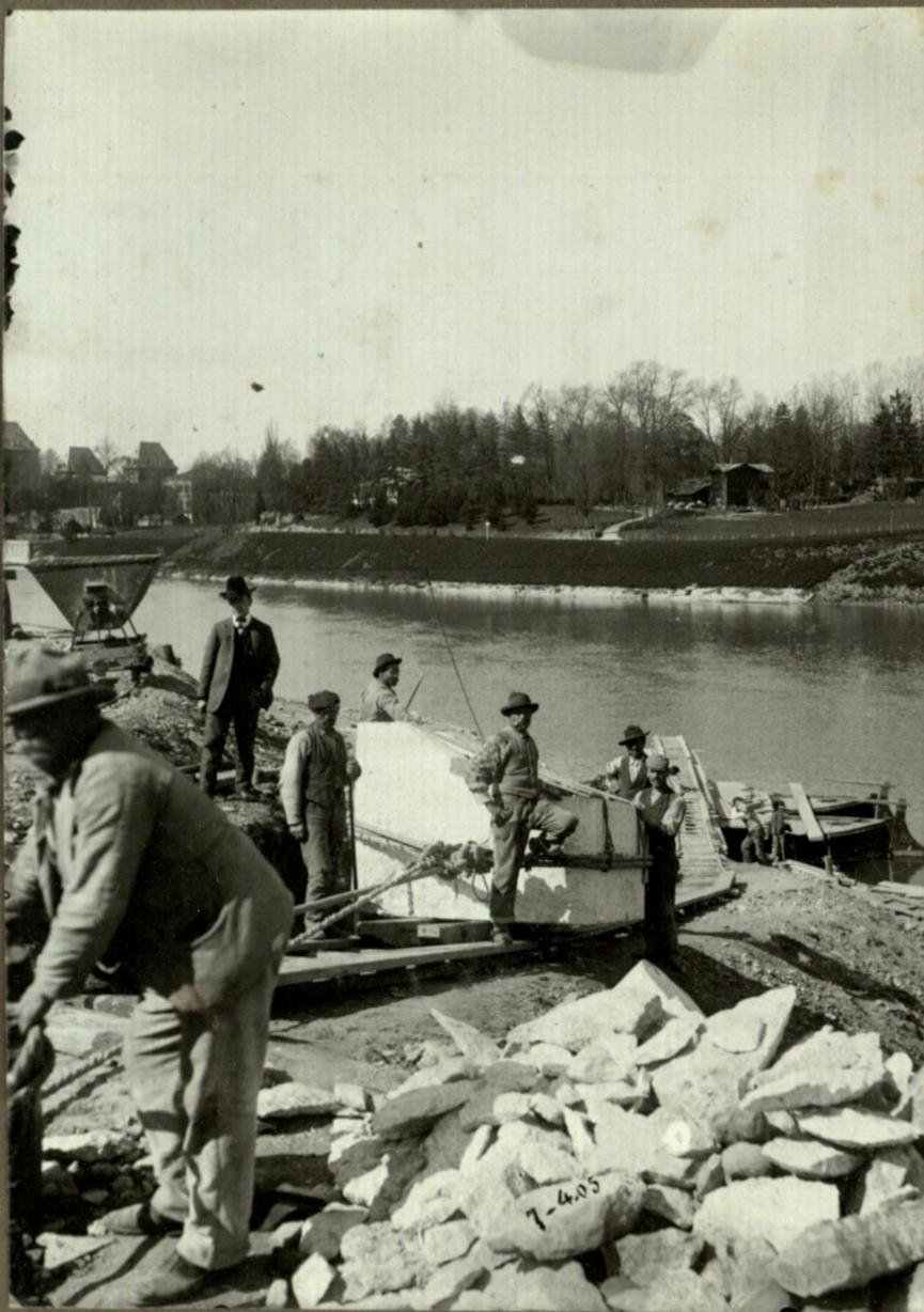
Carico dei blocchi di granito per la sopraelevazione del ponte
