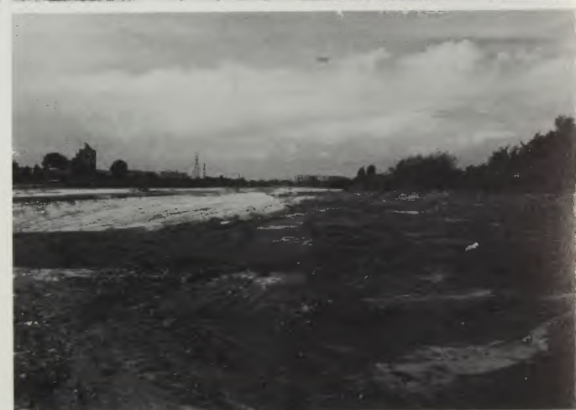
AF9 - La Dora tra il Ponte Mosca ed il « Ponte del Carbone » (F16) AF10 - La Dora nel tratto contenuto da muri d'argine (F15) AF11 - La Dora nel Parco della Pellerina (F22) AF12, AF13 - La Stura a monte del Ponte Ferdinando di Savoia (F4) AF14 - La confluenza della Stura nel Po (F3) AF15 - Il Sangone, non identificabile, sotto il ciglione del Castello di Mirafiori (F39)
