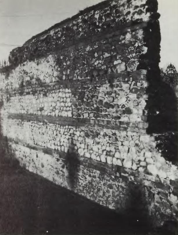
f1 - Tratto della cortina muraria a settentrione, adiacente la Porta Palatina. Fronte verso la città con rivestimento in ciottoli di fiume spaccati, disposti in corsi regolari. Doppi filari di mattoni bipedali interrompono la struttura muraria per segnare piani di posa orizzontali, diventando nello stesso tempo elemento cromatico (SAP).
