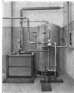
A completamento delle macchine ed apparecchiature di lavanderie, in ogni moderna installazione va aggiunto un depuratore di acqua ZEROLIT a scambio di basi.
