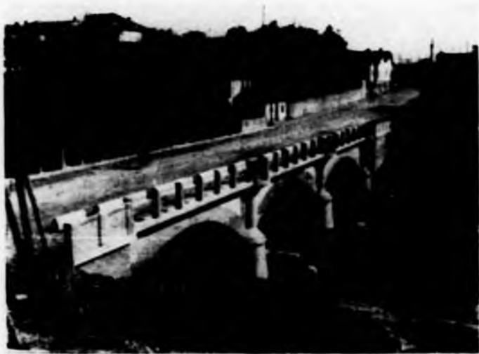
Strada prov. Torino-Orbassano-Piombino Ponte sul Sangone presso Beinasco
