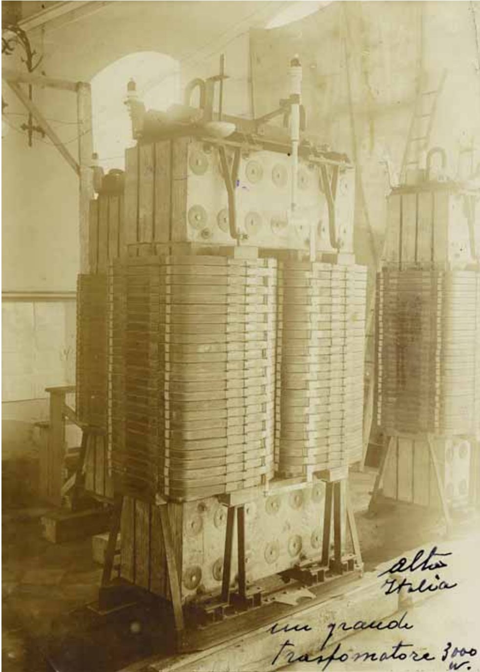
Alta Italia. Un grande trasformatore 3000 w., fotografia sepiata, 1903 (ASCT, Nuove acquisizioni fotografiche, 5/26).
