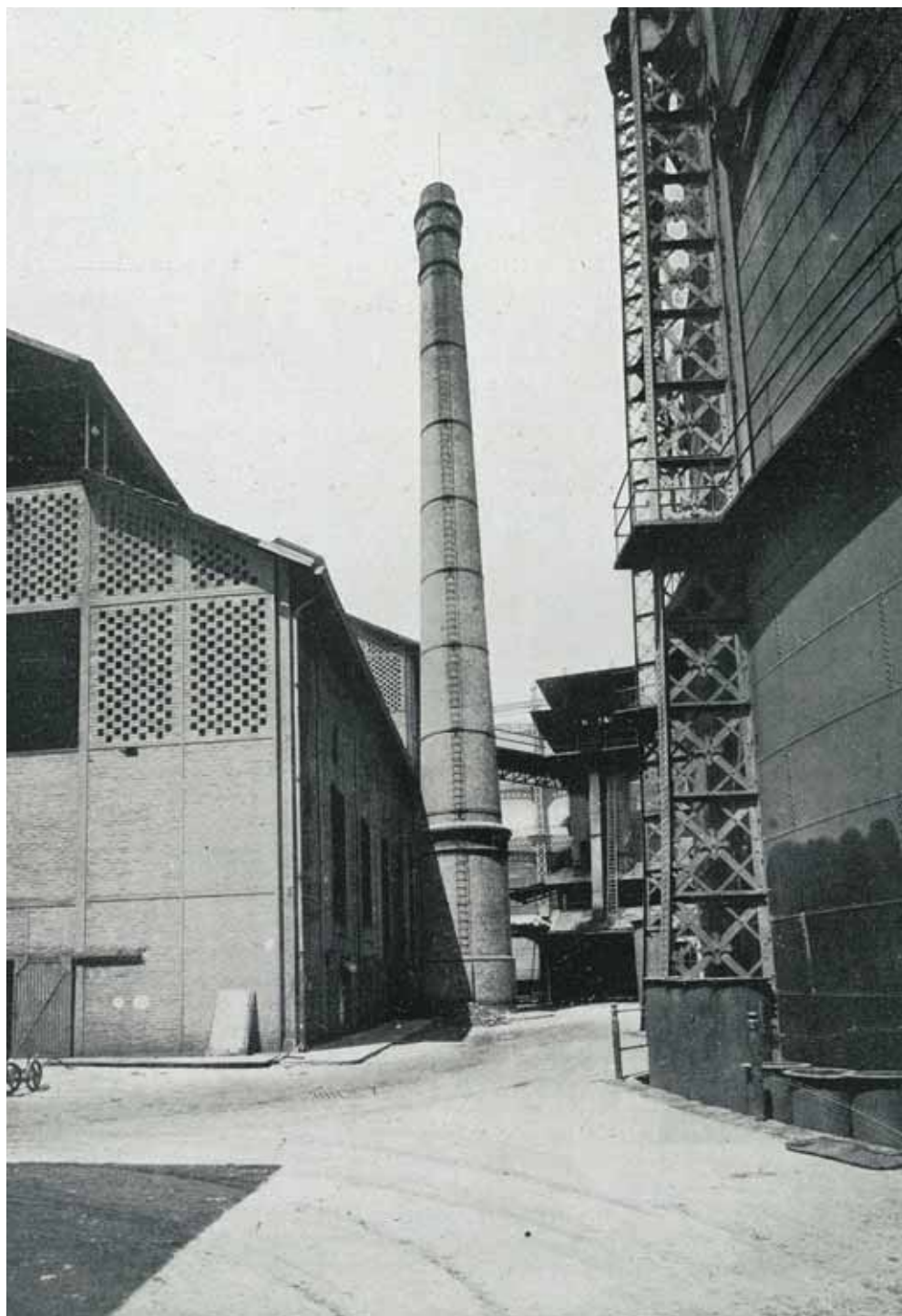
Officina Gas di Borgo Dora, Torino: Elevatore fossile e forni a storte verticali, 1925 (ASCT, «L'Illustrazione Italiana», LII (1925), I, p. 580).
