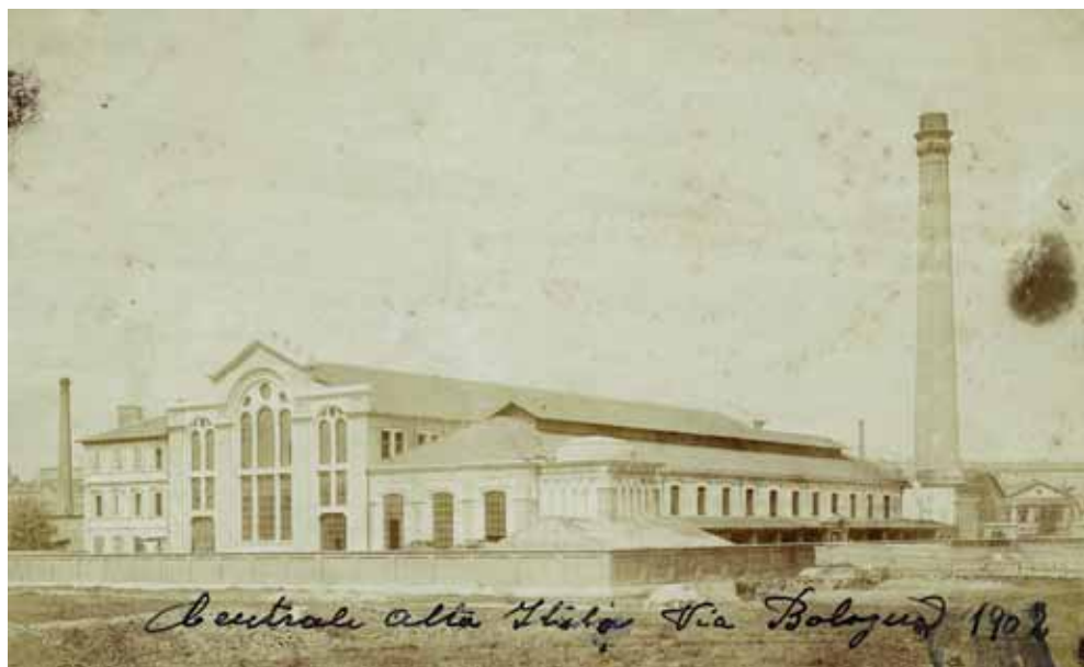
Centrale Alta Italia, via Bologna 1902, fotografia sepiata (ASCT, Nuove acquisizioni fotografiche, 5/27).
