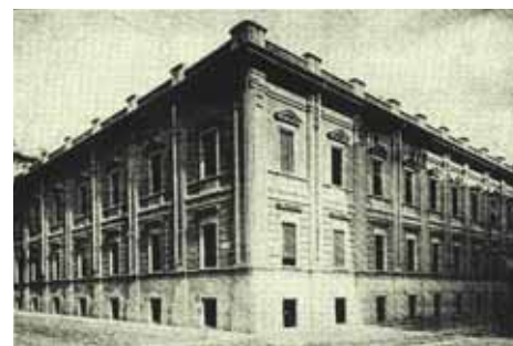
Azienda Elettrica Municipale. Via Bertola angolo via San Dalmazzo, 1928 (ASCT, «Torino», I (1928), n. 2, p. 544).
