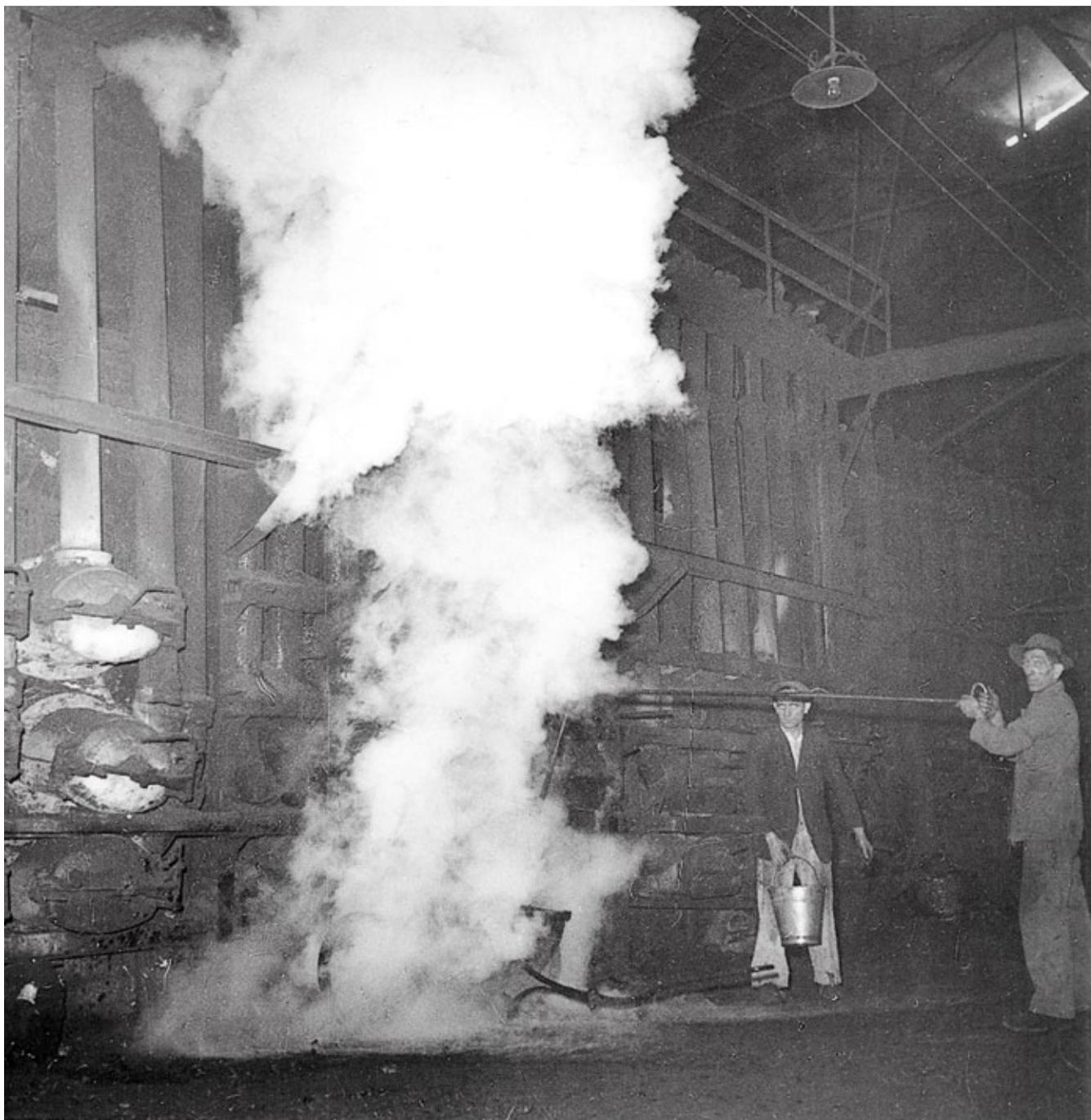
Officina per la produzione del gas, ottenuto per distillazione dal carbone, scaldato in forni a mille gradi, fine '800 (Archivio Storico Italgas).
